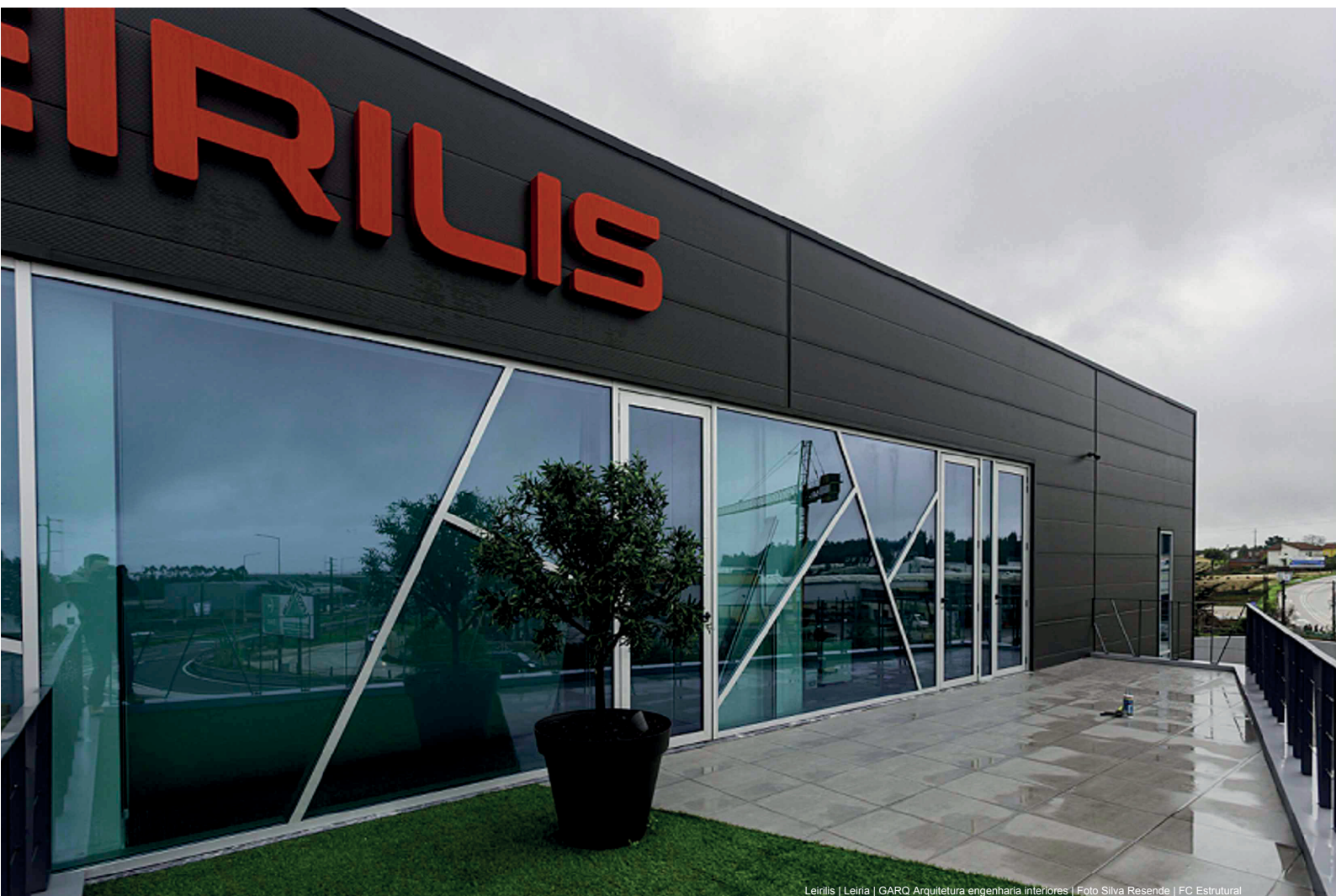
Leirilis | Leiria | GARO Arquitetura engenharia interiores | Foto Silva Resende | FC Estrutural
