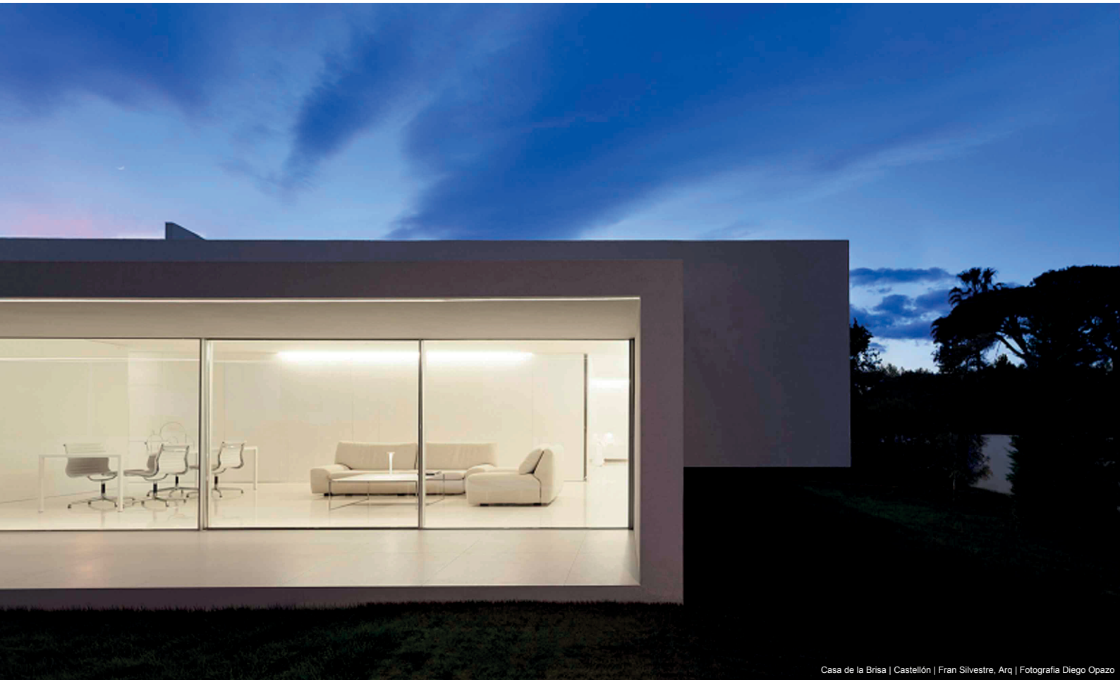
Casa de la Brisa | Castellón | Fran Silvestre, Arq | Fotografía Diego Opazo
