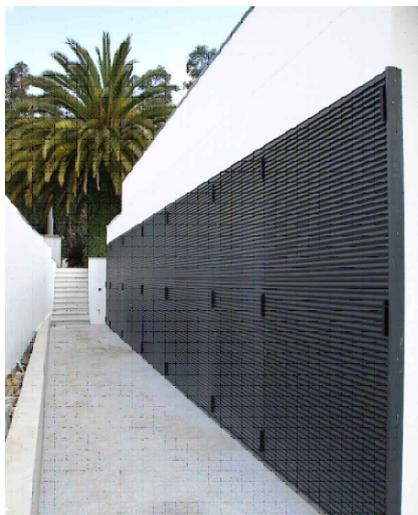
Este sistema foi desenvolvido para o revestimento de fachadas permitindo o encerramento de espaços que exigem a ocultação e a ventilação natural em simultâneo. Pela sua facilidade de montagem (fixação por clipagem nos perfis de suporte), caracteriza-se por ser um sistema de rápida execução.
