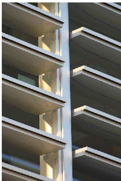
O sistema QS foi desenvolvido para proteger as fachadas dos edifícios da incidência directa da radiação solar. As lâminas de design moderno permitem um enquadramento perfeito em edifícios de arquitectura arrojada, marcando-os pela irreverência.
